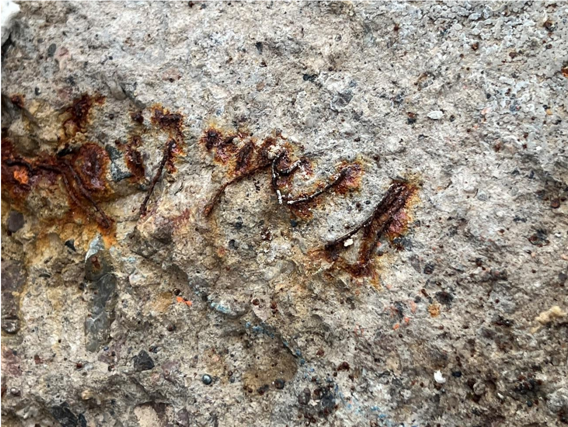
Bild 5: Freiliegendes, korrodiertes Putzgitter / Draht
