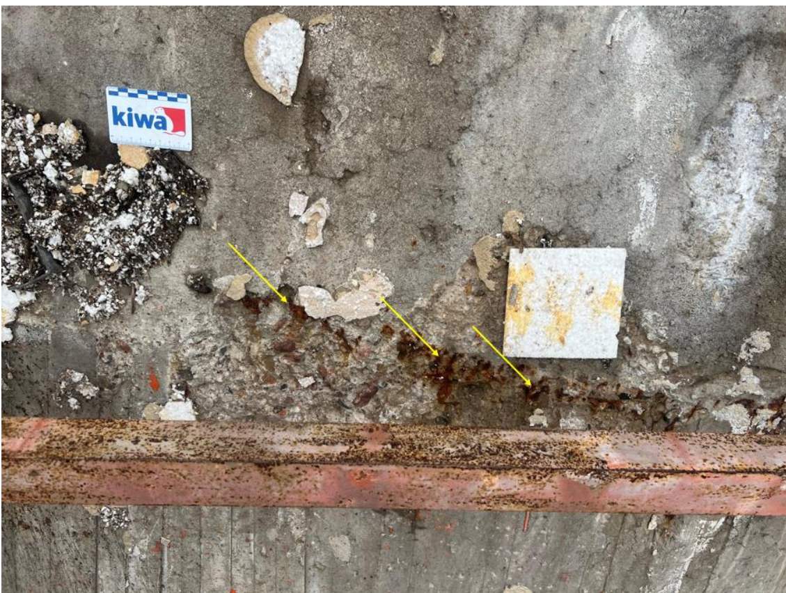
Bild 4: Freiliegendes, korrodiertes Putzgitter / Draht
