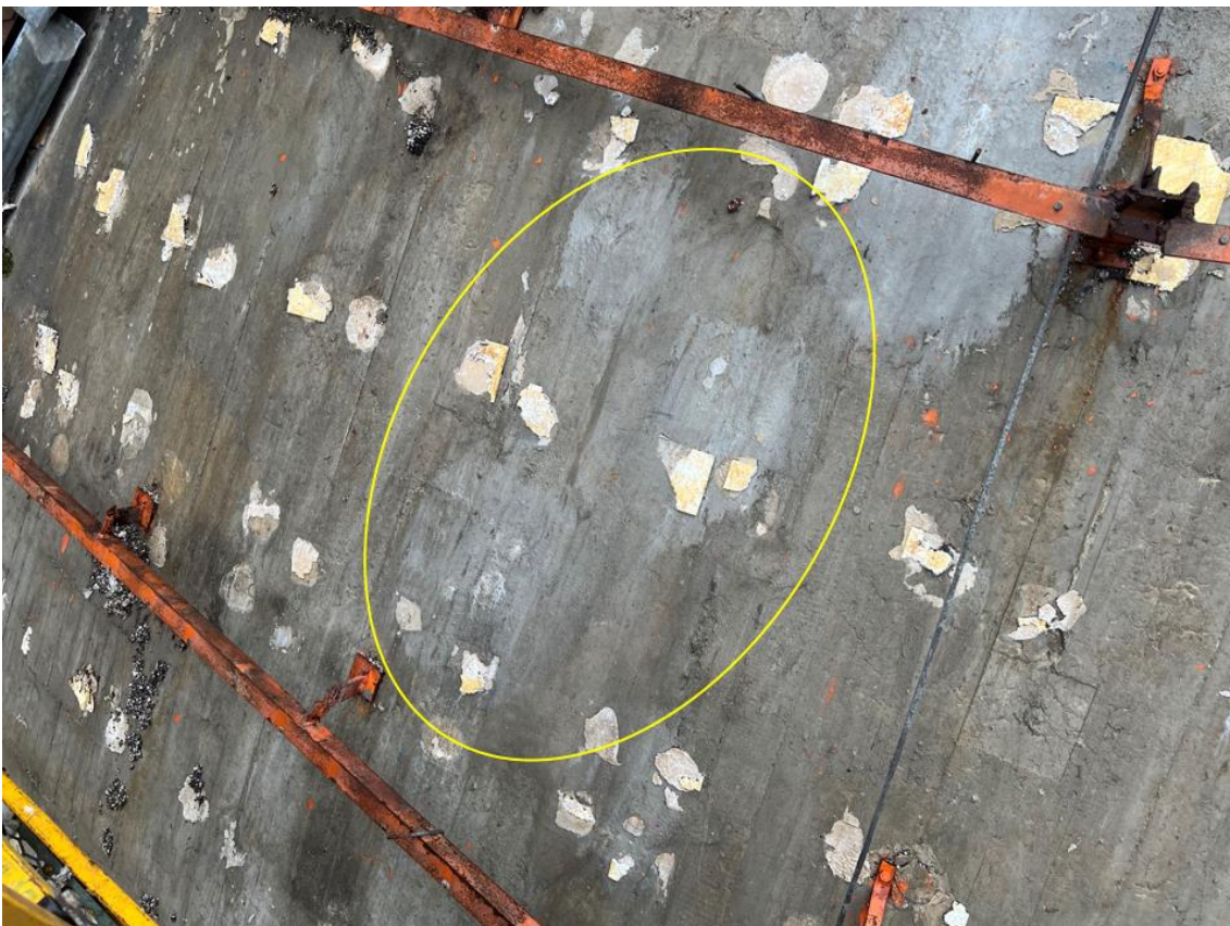
Bild 6 Hohlage an Bauteiloberfläche
