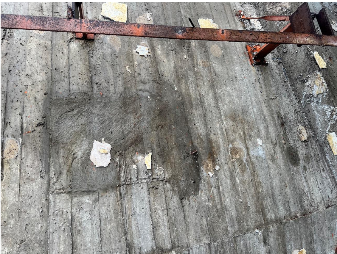
Bild 8: Reprofiliert Bereich Außenoberfläche
