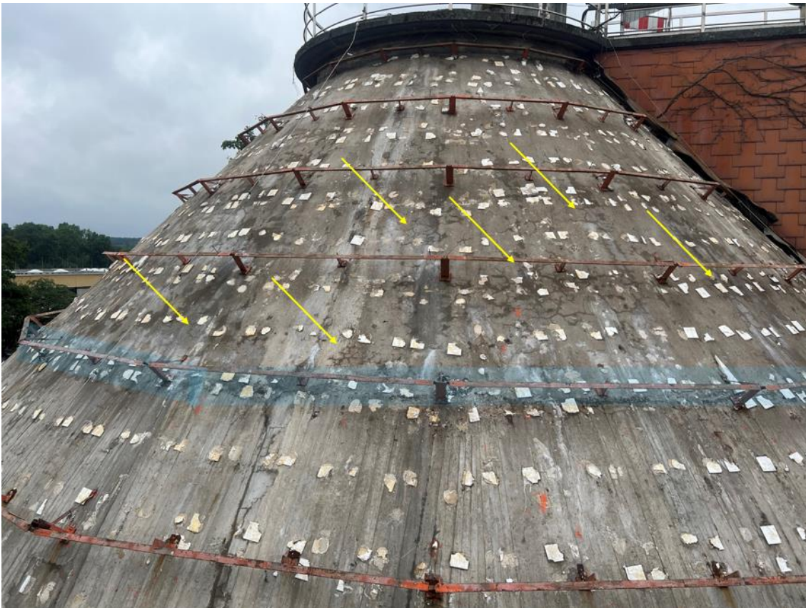
Bild 3 Krakelee Artige Risse im oberen Bereich der Fassade
