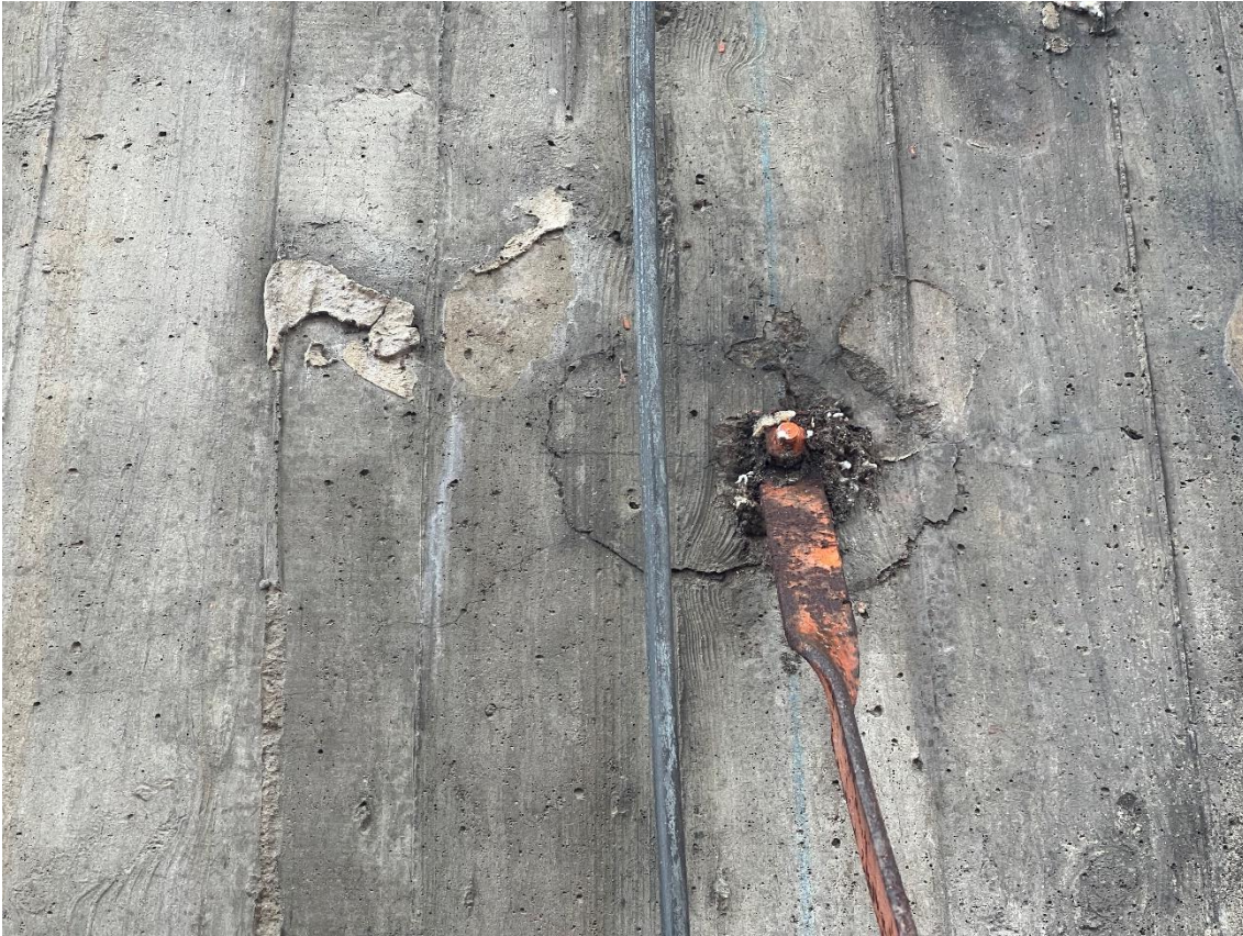
Bild 7: Hohllage an Verankerung
